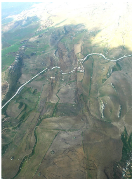
Interruzione del tratto stradale S. P. n° 23 per movimento franoso di C/da "Gorgazzi-Testacotta" in territorio del Comune di Mussomeli
